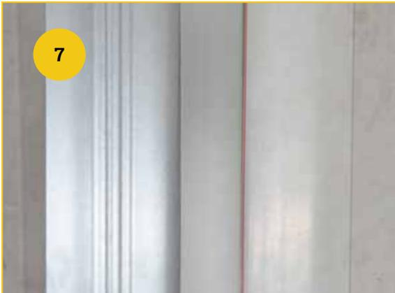
7. CW/UW-Profil an Wand/ Decke/ Boden ansetzen
