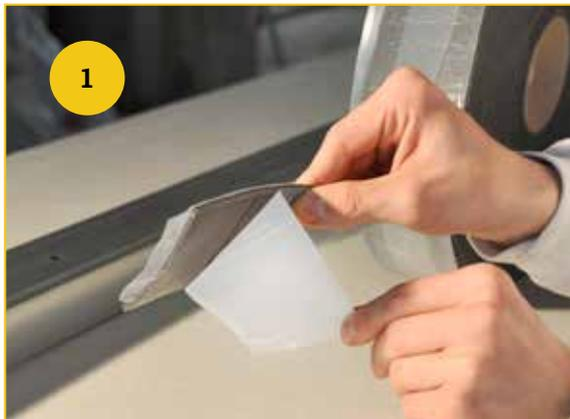
1. Die Silikonfolie an der Unterseite von Montape® abziehen
