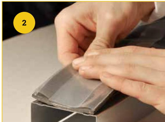
2. Montape® mit der Klebeseite auf CW/ UW-Profil exakt mittig aufsetzen
