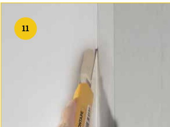
11. Montape® - Trennstreifen flächenbündig abtrennen
