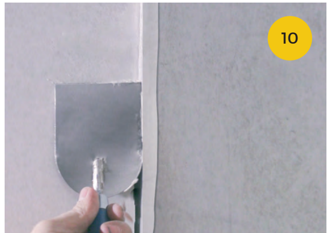
10. Die Fugen planeben verspachteln
