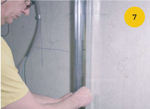
7. UW/ CW-Profil an die Wand/ Decke/ Boden ansetzen
