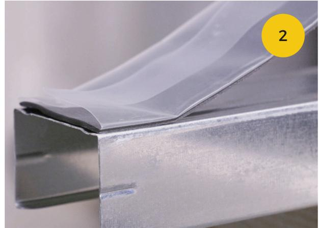
2. MONTAPE® mit der Klebeseite auf CW/UW-Profil exakt mittig aufsetzen
