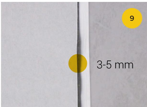
9. Gipskarton-, faser Platte mit ca. 3-5 mm Abstand zum MONTAPE® Trennstreifen montieren
