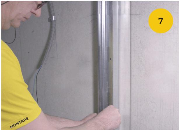
7. CW/UW-Profil an Wand/ Decke/ Boden ansetzen
